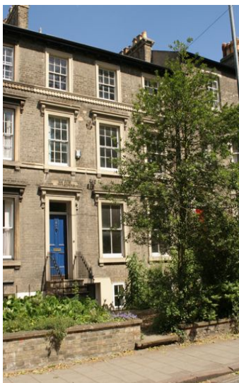
Nº 4 Newnham Terrace!
